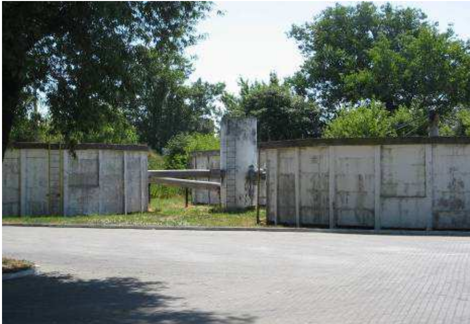
Teren oczyszczalni ścieków na obszarze E przeznaczonym do rewitalizacji.
